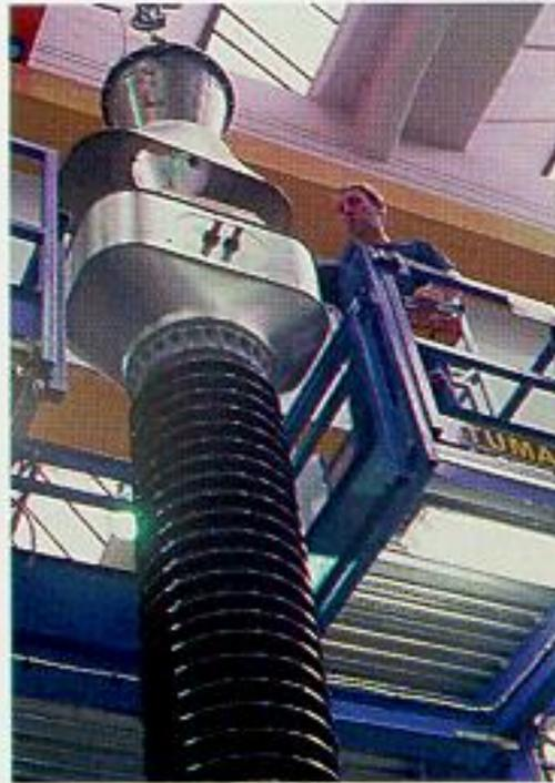
**Los AOK, transformadores de corriente con el núcleo en la parte superior son dimensionados para muy altas tensiones.**
